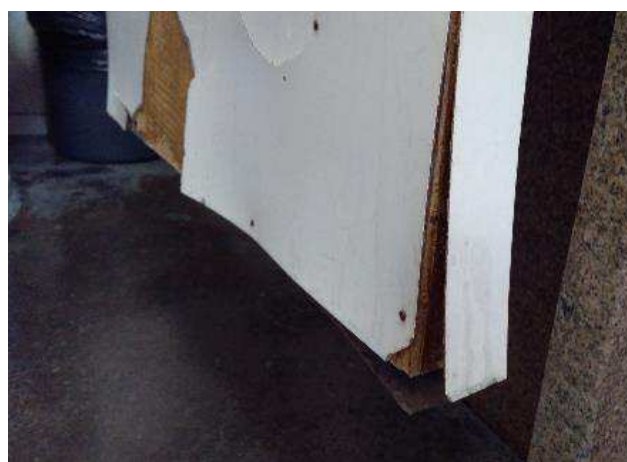
Figuras 19 e 20: Portas de madeira danificadas pela umidade.
