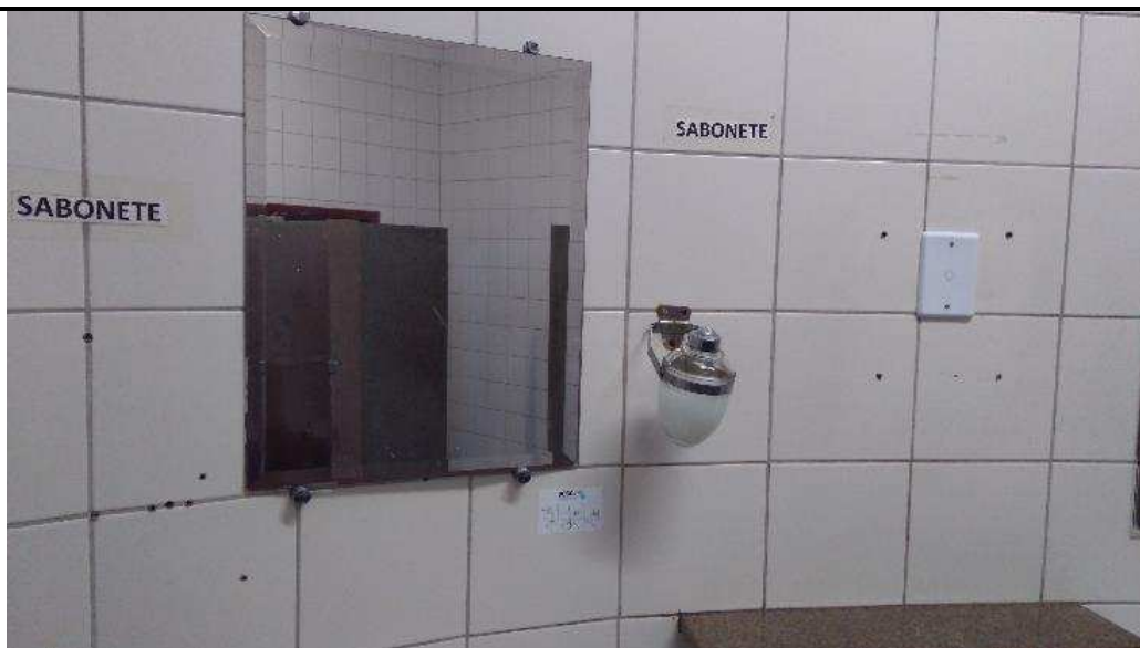
Figura 13: Furos na cerâmica.
