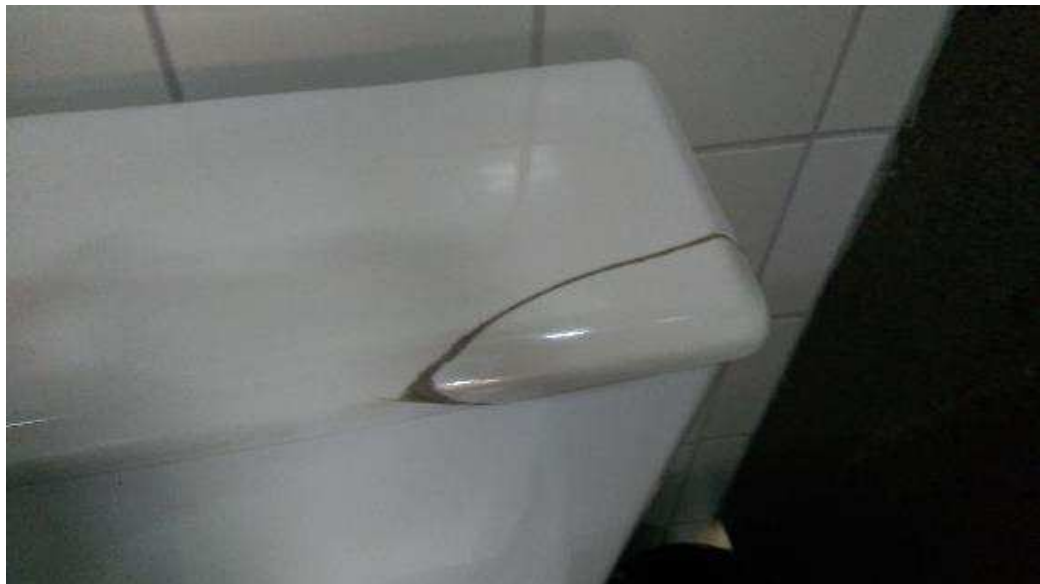
Figura 17: Trinca na tampa da caixa acoplada do vaso sanitário.
