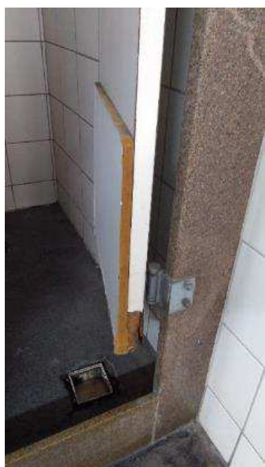
Figuras 21 e 22: Portas de madeira danificadas pela umidade.
