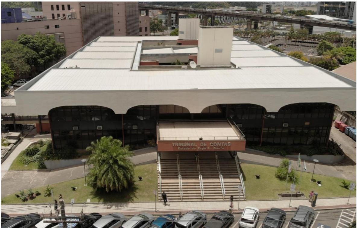
Figura 02: Edificação do TCEES, com destaque para a cobertura.
