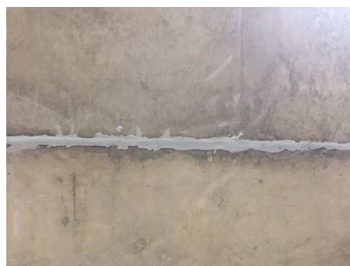
Figura 15: Junta de dilatação - teto.
