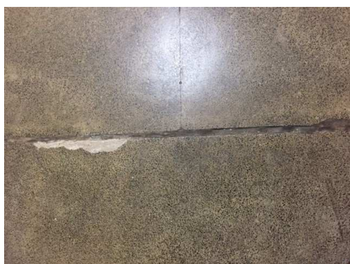
Figura 14: Junta de dilatação - piso.
