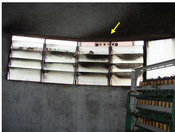
FOTO 22 – Detalhe de aberturas de ventilação na parede do fundo da casa de máquinas do ELEVADOR DA FRENTE.
