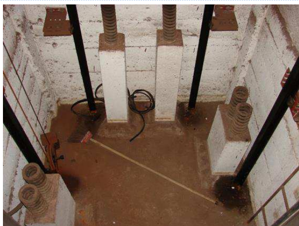
FOTO 17 – Detalhe do poço do ELEVADOR DO FUNDO.
