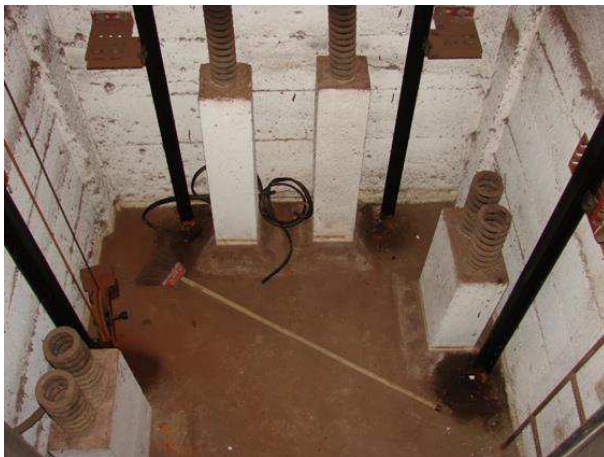
FOTO 17 – Detalhe do poço do ELEVADOR DO FUNDO.
