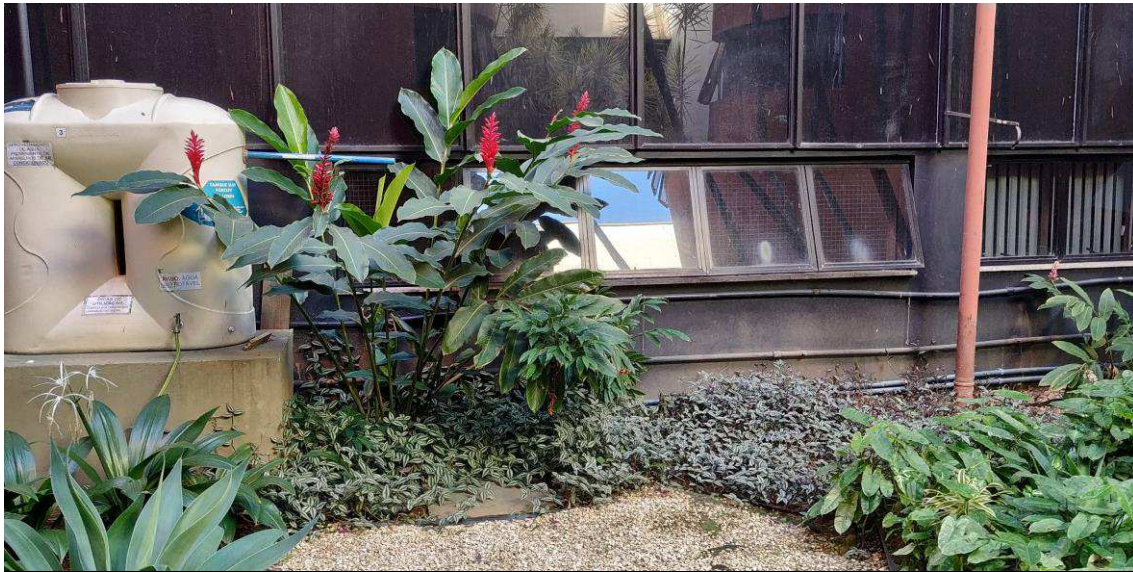
Figura 30: Local para retirada de esquadria e abertura de vão para portinhola de acesso à casa de bombas
