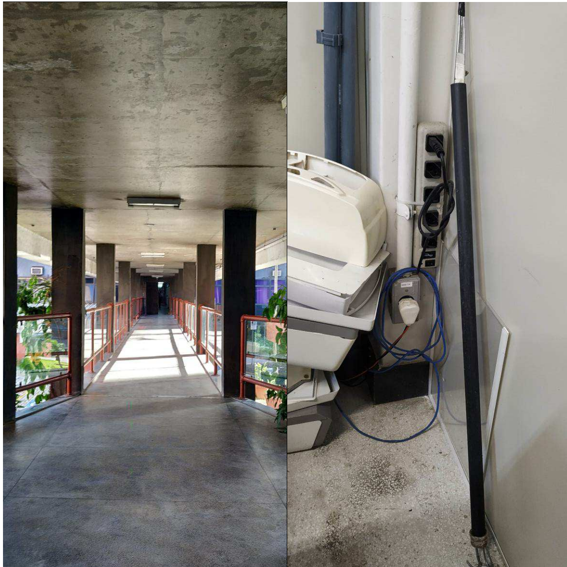
Figura 36 e 37: Instalações aparentes
