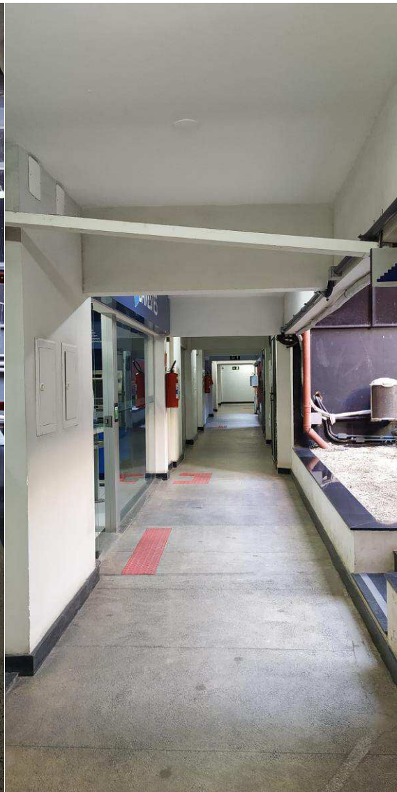
Figura 27: Trecho corredor térreo
