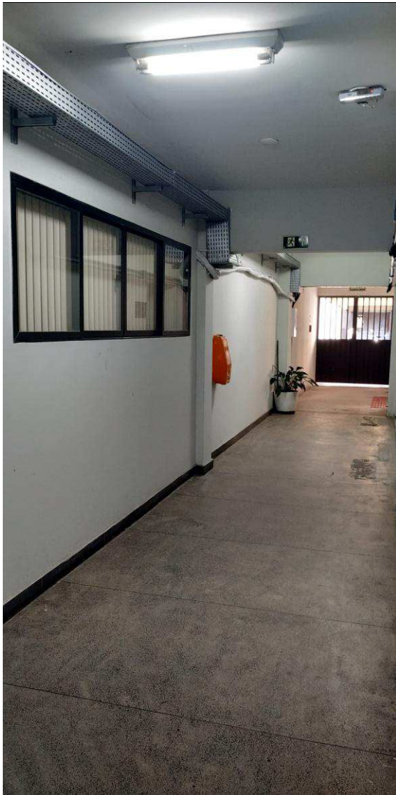
Figura 28: Instalações aparentes (segue para cantina)
