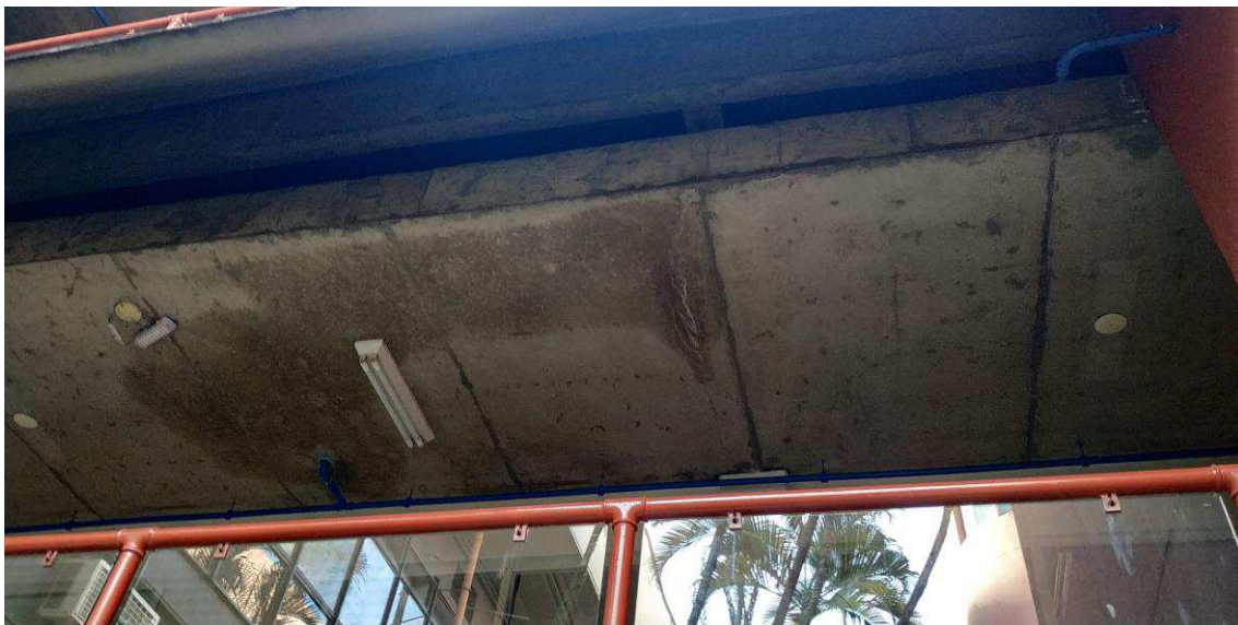
Figura 31: Vão “entre lajes”
