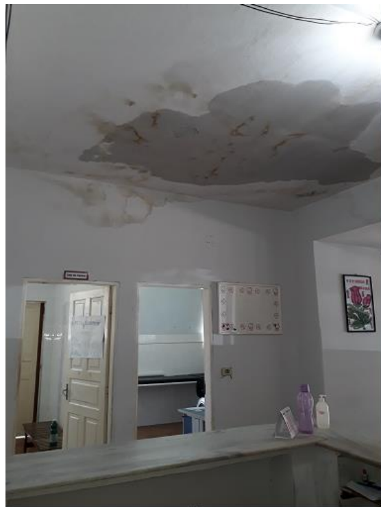
Figura 17. Sala de vacinação no município de Boa Esperança - Rede de frio.
