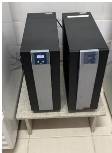
Figura 61. Duas baterias externas ( nobreks ) acopladas a uma geladeira (UBS Dr. César Vello Puppim - Marechal Floriano)
