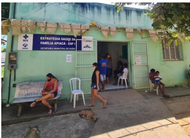
Figura 20. Unidade de Saúde da Família - US3 município de Apiacá onde se localiza a sala de vacinação.
