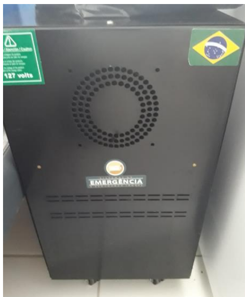
Figura 60. Bateria externa ( nobrek ) acoplada a câmara refrigerada (Rede Frio - Jaguaré)
