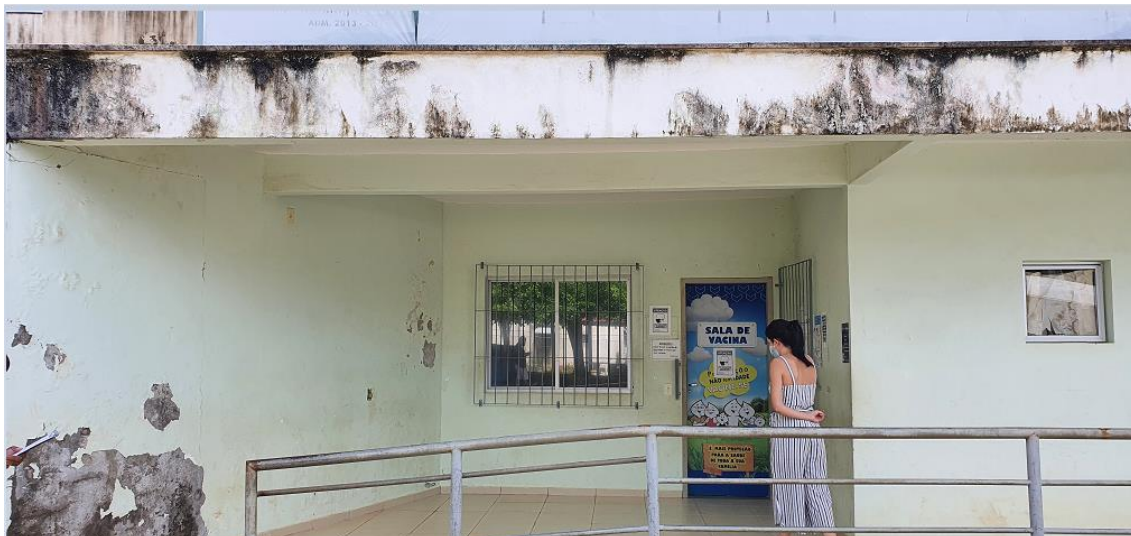
Figura 22. Sala de Vacinação do Centro administrativo de saúde Hilário Piantavinha no município de São Domingos do Norte.
