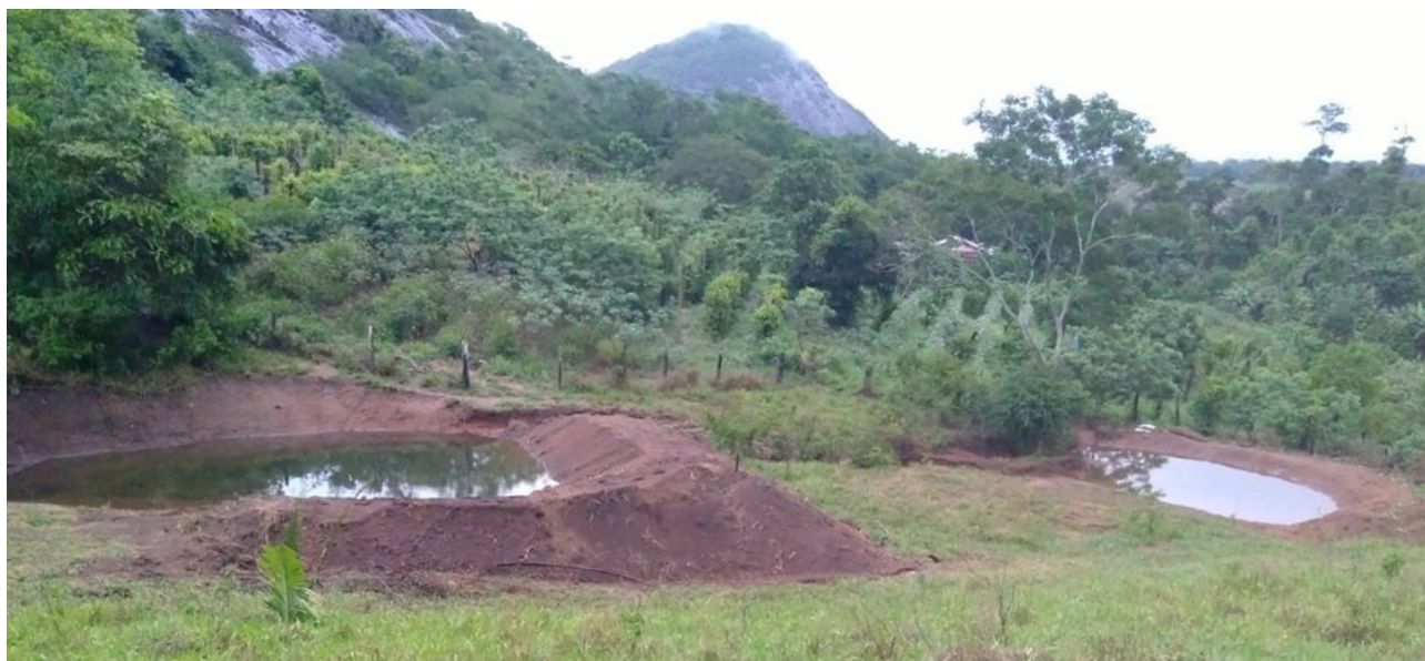
Figura 28. Exemplo de barraginha construída
