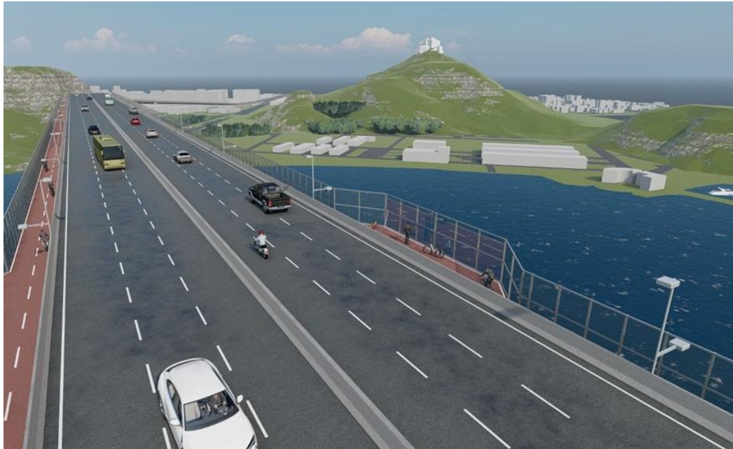
Figura 11: Ampliação do número de pistas na Terceira Ponte
