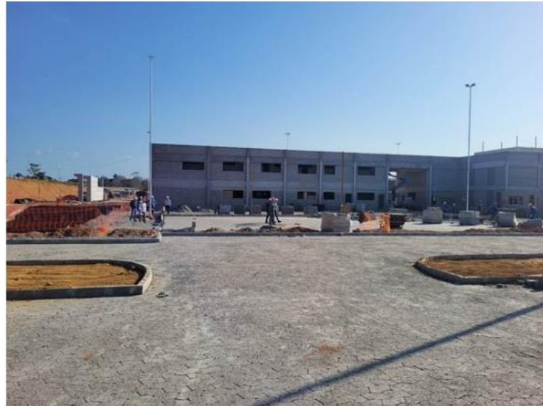
Foto 2: Obra da Penitenciária Estadual de Vila Velha – PEVV VI
