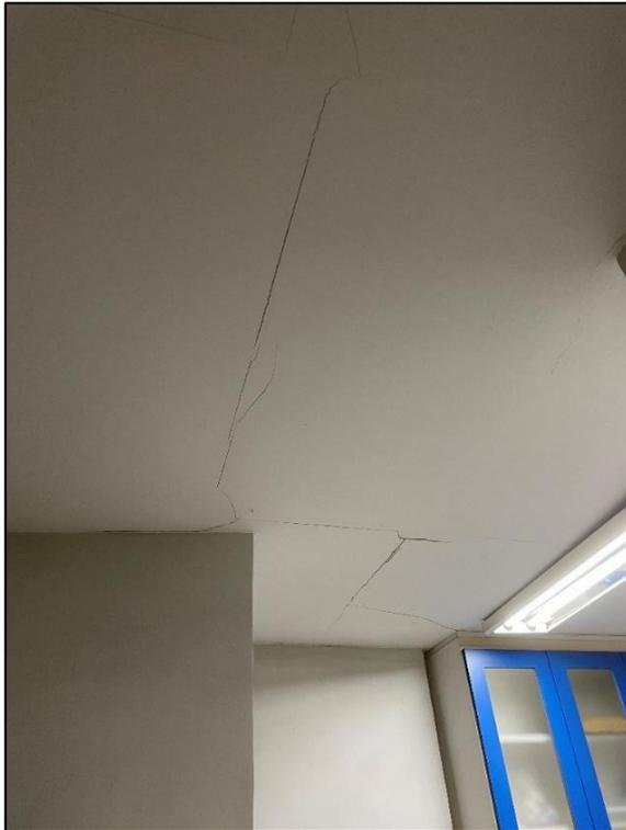
Foto 5: Trincas ou rachaduras no teto (2º DP - Vitória)
