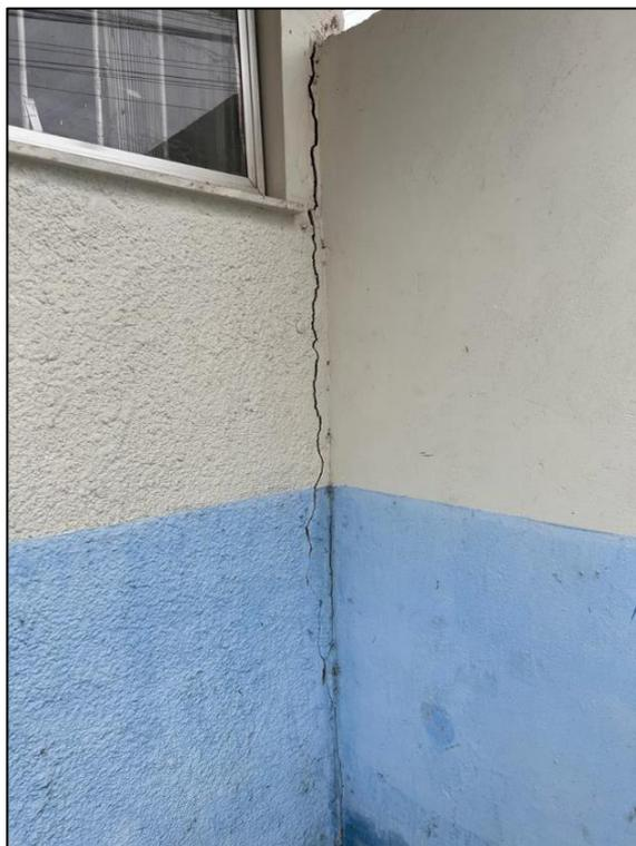
Foto 7: Trincas ou rachaduras nas paredes (9º DP - Vila Velha)
