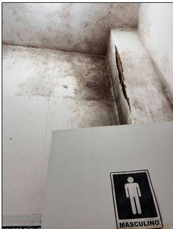
Foto 3: Infiltrações nas paredes (7º DP – Vila Velha)
